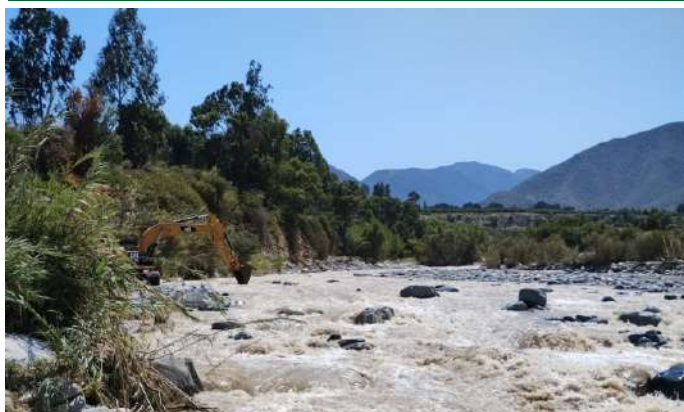
Maquinaria pesada atendiendo puntos críticos en Los Molinos.
