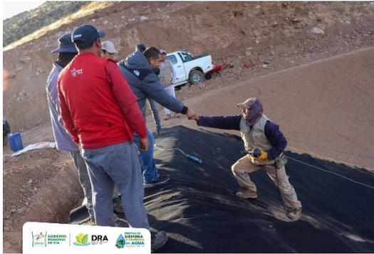
En la Comunidad de San Andrés de Quilcanto, se ejecutan los trabajos de impermeabilización con la instalación del geotextil y geomenbrana en los reservorios. El equipo técnico constata la correcta colocación de ambos materiales, buscando que en temporadas de lluvias se logre almacenar la mayor cantidad de agua posible y ser usada en tiempos de estiaje.
